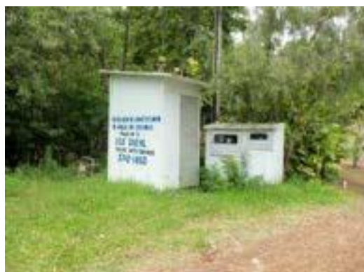
Figura 24 – Vista geral do Poço e Casa de Química da Rua Guilherme Jacobs
