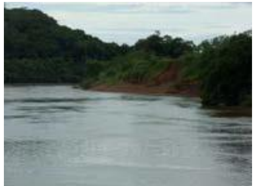
Figura 51 – Erosão da margem do rio Taquari
