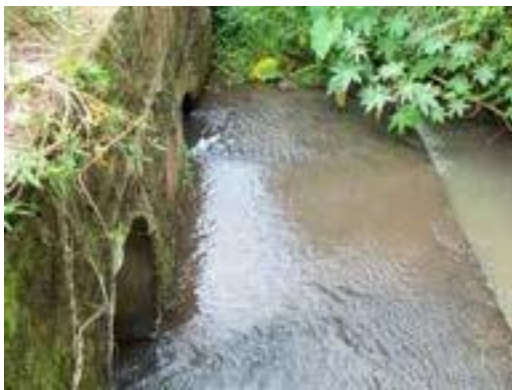
Figura 36 – Bueiros do sistema de drenagem
