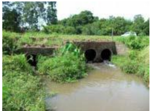
Figura 41 – Bueiros do sistema de drenagem da estrada
