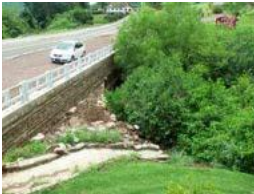
Figura 34 – Travessia sobre o Arroio Pajé
