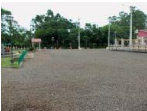
Figura 38 – Vista geral da Praça, onde ocorre alagamento
